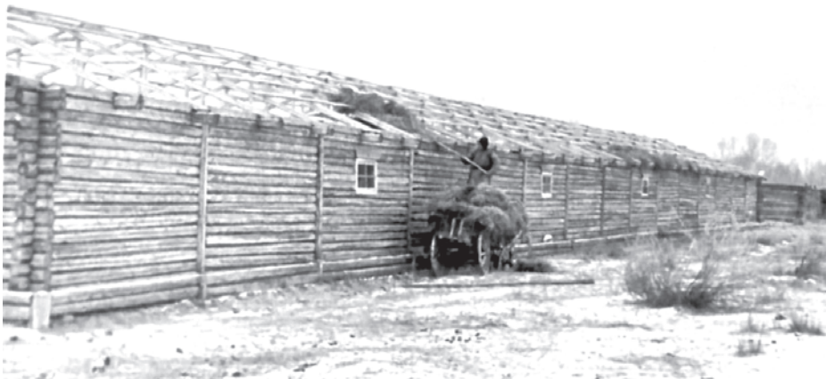
Рис. 59. Типовой коровник в колхозе «Мурнакчи». Колхозники кроют крышу соломой [фото Е.Д. Прокофьевой. Архив МАЭ РАН]
