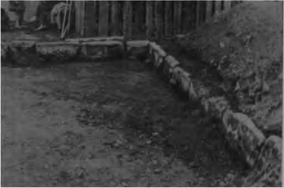
Рис. 191. Вид юго-восточного угла ограды № 5 в Усть-Буре после расчистки
